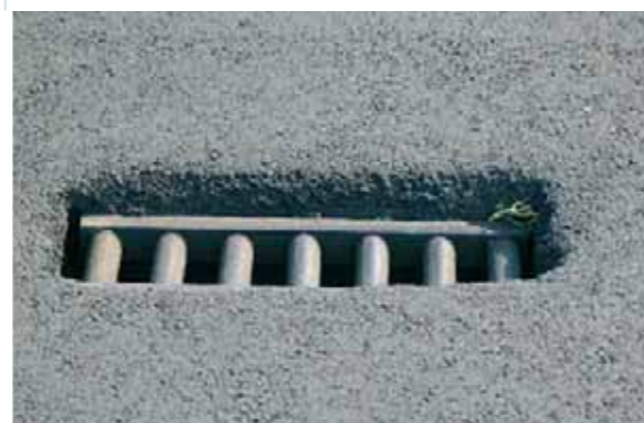
De roosters van de straatkolk moeten dwars op de rijrichting liggen.
