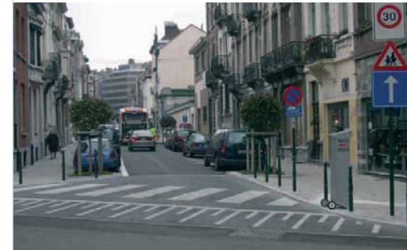
Een plateau in een stadscentrum bij het binnenrijden van een schoolomgeving (merk wel op dat het bord A23 boven het bord F4a geplaatst had moeten worden).
