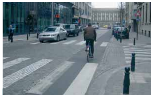
De fietsuggestiestrook is aangelegd in een materiaal dat de tweewielers meer comfort biedt.
