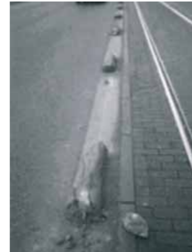
Beschadigde biggenruggen verbrossen of kunnen loskomen en worden zo een nog groter gevaar voor de weggebruikers.
