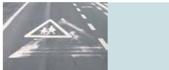
De markering die vroeger de volledige wegbreedte in beslag nam, is nu veel kleiner, gemotoriseerde tweewielers kunnen nu naast de markering rijden. De oude markering is niet volledig verwijderd zoals aanbevolen in 5.7.3.
