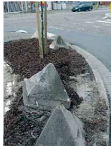
Piramideblokken worden vaak geplaatst met dezelfde functie als schampblokken.
