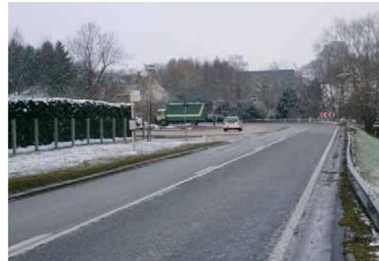
Een bocht van categorie C, aangeduid met een meervoudig horizontaal afbakeningsbord (op de foto ontbreekt het verkeersbord A1).
